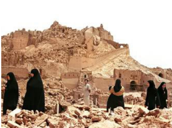
شکل ۶- بقایای ارگ بام پس از وقوع زلزله
